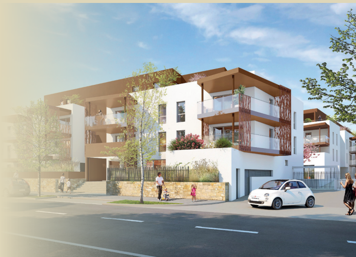
Résidence Ideom 63 appartements en primo accédant du T1 au T4. Livraison fin 2018
